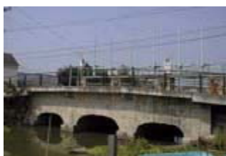
妹尾三連樋門
