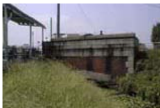
桜の馬場樋門
